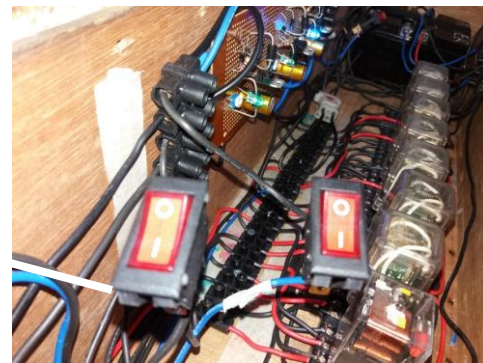
Gambar 11. unit kontrol pada mobil sel surya.
