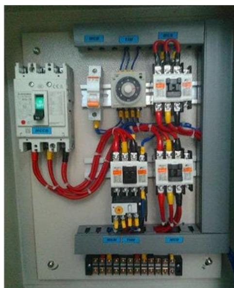
Gambar 1. Ilustrasi Panel rangkaian *star-delta*
